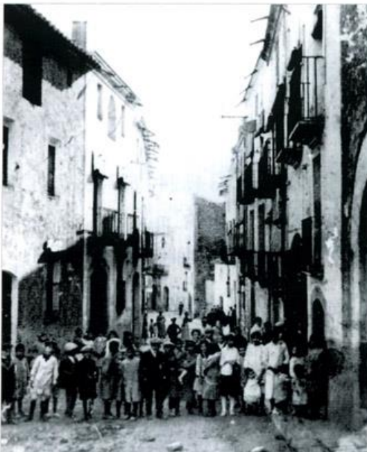
Carrer del Francesc Riba i Mestre anys vint. Darrere la mainada, a la dreta, el que seria el Casino de Baix. (Foto Arxiu Municipal)
