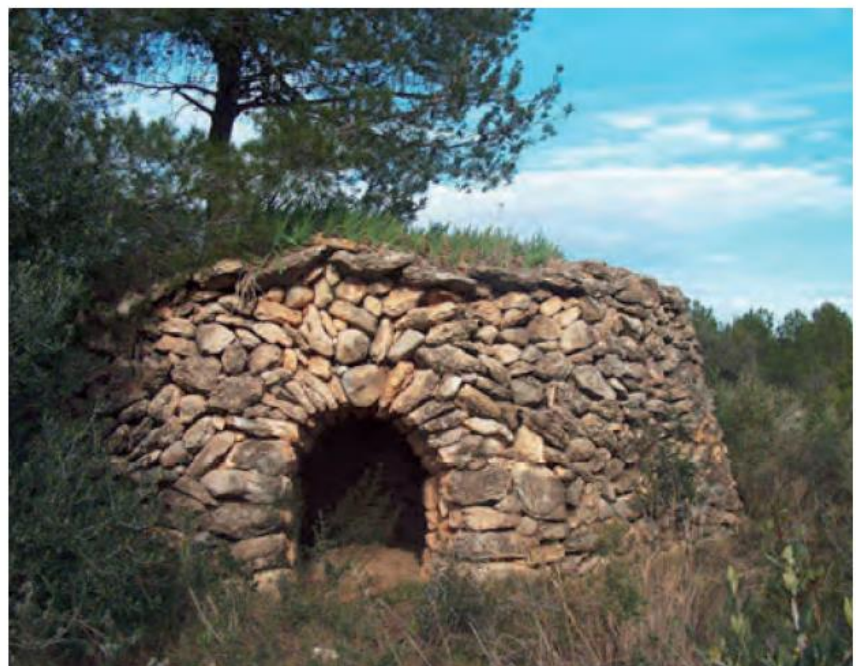
■ La barraca dels lliris, a la imatge, té a la part exterior del sostre una capa de terra i pedruscall amb lliris de Sant Josep plantats. Aquesta tècnica, molt utilitzada en barraques de sostre pla o semipla, es feia servir perquè les fines arrels dels lliris relliguessin i aïllessin millor la coberta. FOTOGRAFIA: ESTHER BARGALLÓ BARGALLÓ.
