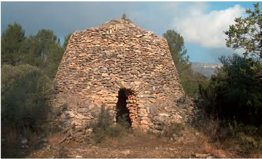
■ Barraca dels Comuns del Pellicer. Aquesta barraca acabada en punxa destaca per la tècnica emprada en la seva construcció, consistent en el possible reompliment de l'interior amb branques d'arbres per tal d'anar guanyant altura. L'interior és de planta circular i s'hi accedeix per un portal força alt, de muntants verticals i arc pla. La coberta és de terra i grans lloses. FOTOGRAFIA: ESTHER BARGALLÓ BARGALLÓ.
