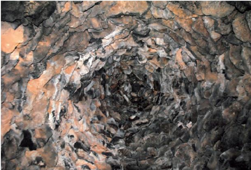
■ La coberta de la cabana dels Comuns del Pellicer arrenca amb falsa cúpula i acaba en cúpula. FOTOGRAFIA: ESTHER BARGALLÓ BARGALLÓ.
