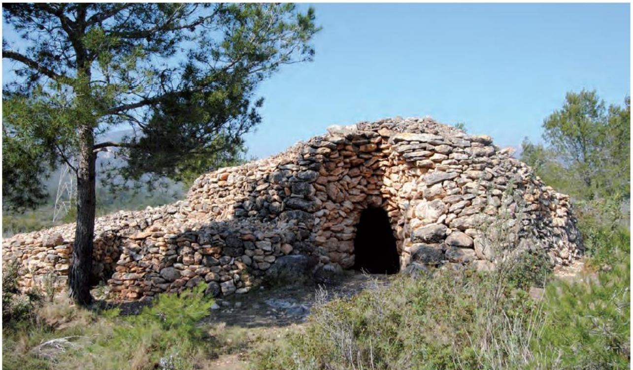
■ Exterior de la barraca del Miquel Terna. Hi destaca el portal, amb muntants arquejats acabats en arc de mig punt, que abasta tota l'amplada de les parets. Al seu interior, de planta circular, el sòl és una gran llosa de pedra que fa baixada des de l'exterior, conformant una mena d'aljub per recollir l'aigua de la pluja. La façana es perllonga, pel costat esquerre, en un cos més baix de planta semioval, que inclou una dependència de planta rectangular que en una fotografia de 1967 s'observa que estava coberta; encara ara, al fons, s'hi aprecia una mena de banqueta de pedra o menjadora. FOTOGRAFIA: ESTHER BARGALLÓ BARGALLÓ.
