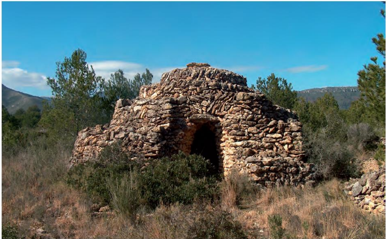
■ Barraqueta en espiral. La seva forma helicoidal facilita l'accés a la gran pedra cobertora que corona el sostre, que és practicable, fet que permetia l'evacuació directa del fum en cas d'encesa de foc a l'interior. La façana presenta un portal d'arc d'ametlla amb muntants arquejats i una llinda. La coberta és de cúpula i el recobriment de pedruscall. FOTOGRAFIA: ESTHER BARGALLÓ BARGALLÓ.
